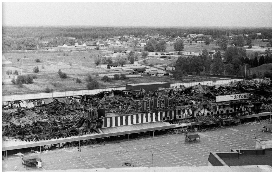
Zniszczone centrum handlowe na obrzeżu miasta. Na parkingu przed nim niegdyś odbywały się wieczorowe spotkania rolkowe. Zdjęcia zrobione z dachu 14-piętrowego blokowiska. Czernihów, 2022.
