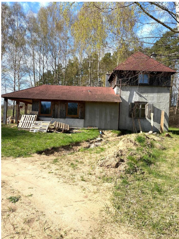
Fot. 6. Nowoczesny dom posiadający elementy starego budynku (fot. Aleksandra Sząszor,).
